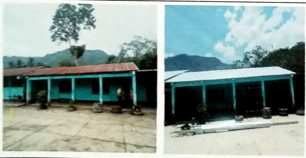
Foto 9: Vista Exterior Frontal de Modulo de aulas B se cambio cubierta de lamina de zinc por lamina troquelada cal 26. Se sustituyo estructura de madera en mal estado por estructura de metal a base de vigas y costaneras
