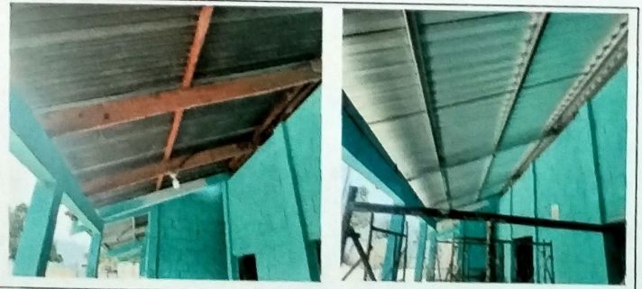
Foto 12: Vista Exterior corredor de Modulo de aulas B se cambio cubierta de lamina de zinc por lamina troquelada cal 26. Se sustituyo estructura de madera en mal estado por estructura de metal a base de vigas y costaneras
