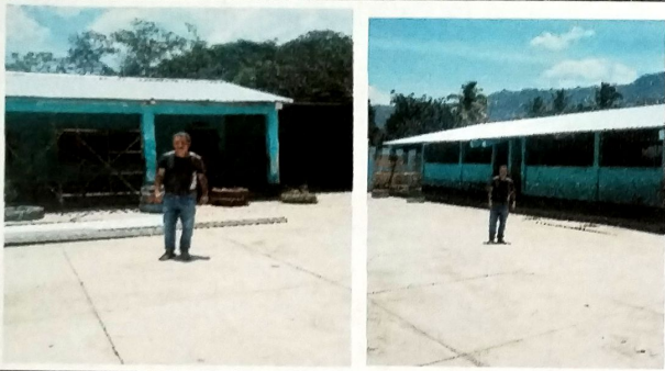
Foto1: Vista exterior de Modulos de Aulas a la izquierda Modulo B y a derecha Modulo de Aulas C que se cambio cubierta de lamina de zinc por lamina troquelada cal 26.
