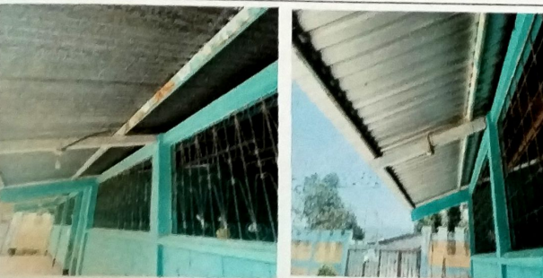
Foto 5: Vista corrido de Modulo de aulas C se cambio cubierta de lamina de zinc por lamina troquelada cal 26.
