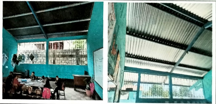
Foto 8: Vista Interior de Modulo de aulas C se cambio cubierta de lamina de zinc por lamina troquelada cal 26.
